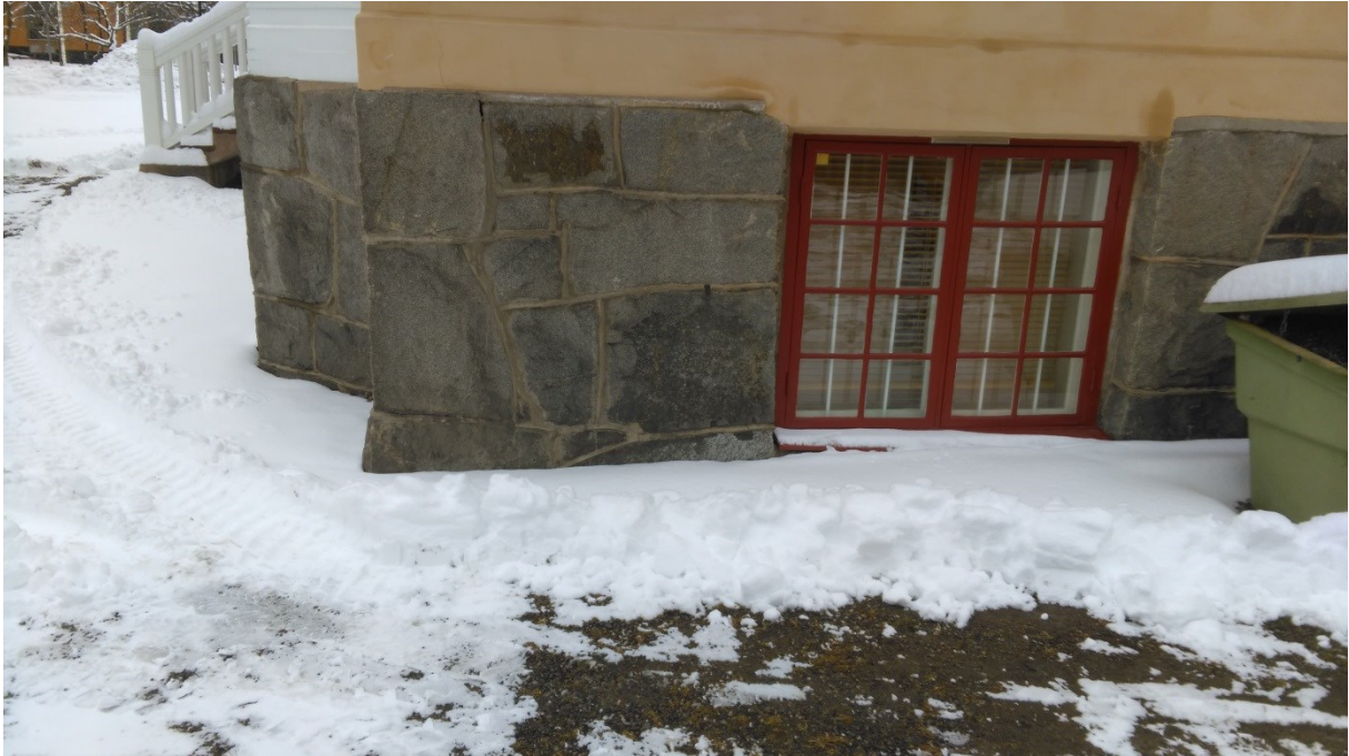
Figur 1.2 Närbild av yttre källarvägg. Cirka en meter av källarväggen ligger under marknivå.
