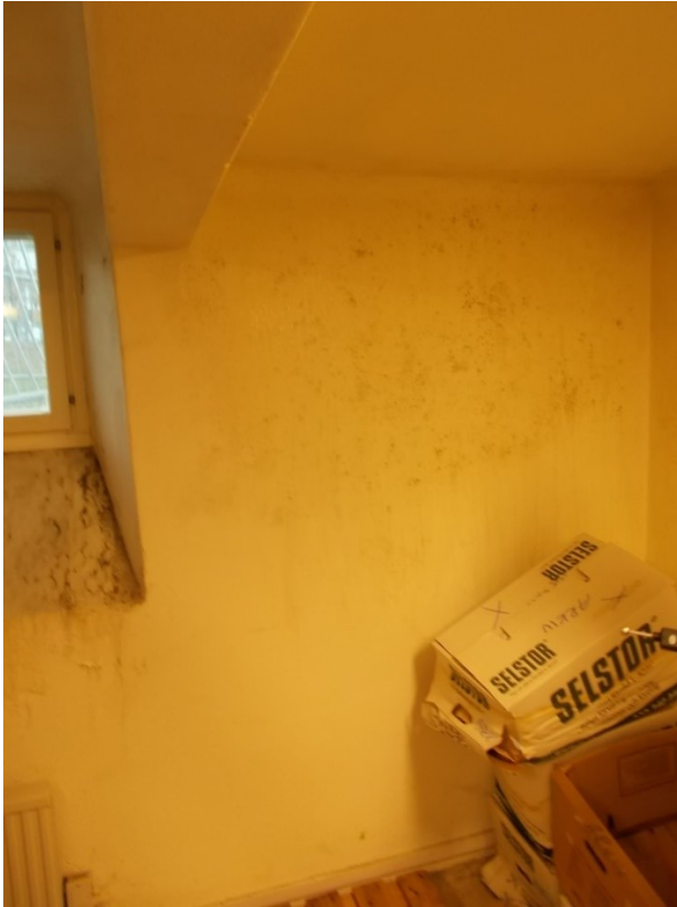
Figur 1. Röda korset: Vägg med kondens
