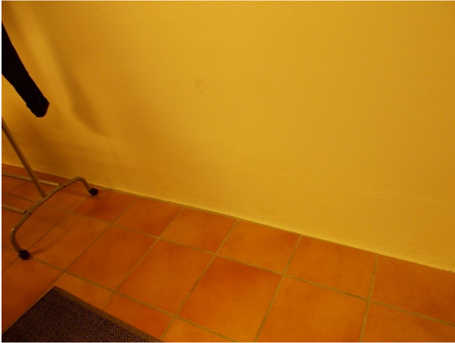
Figur 5.6 Bagarmossen: Yttervägg med installation.
