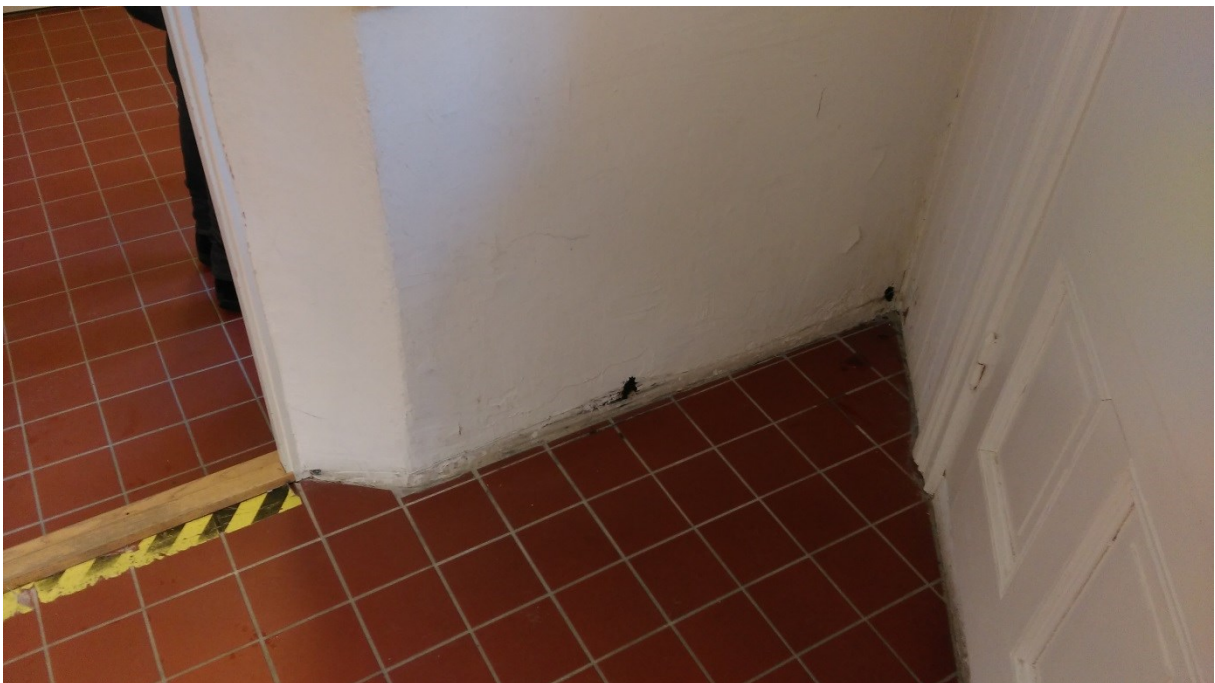
Figur 1.5 Innervägg med installerade elektroder.
