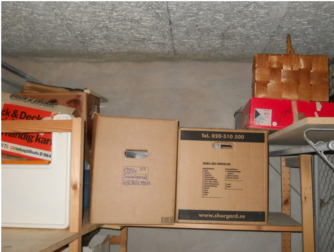
Figur 2.5 Bilden visar anslutning mellan tak och vägg i förrådsutrymmet.
