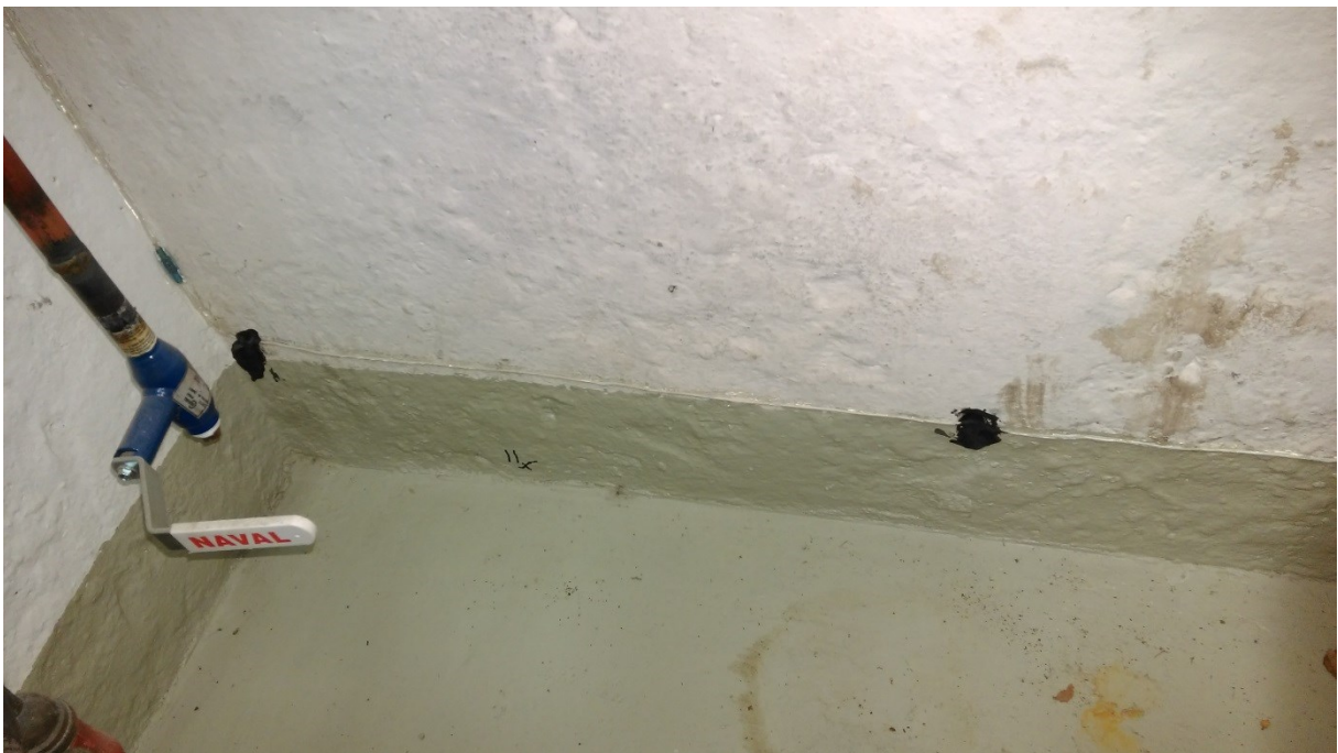
Figur 1.3 Anoder av insticksmodell installerade ca 10 cm ovanför golvnivå med cirka 70 cm.
