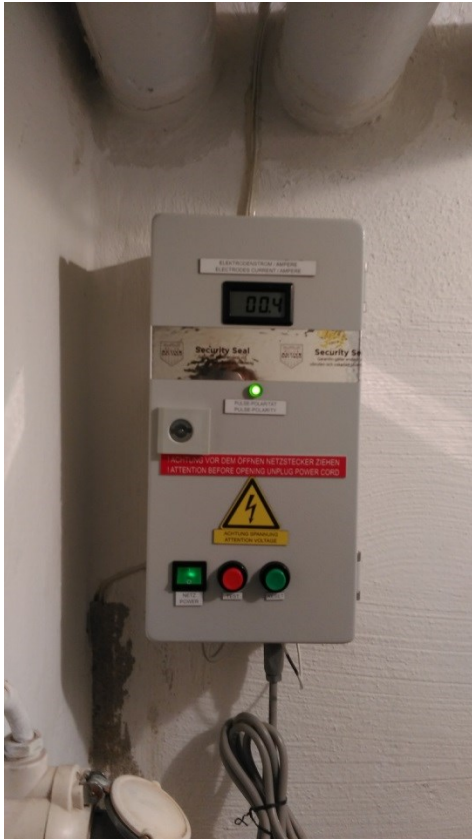
Figur 4.1 Hammarbyhöjden. Den nya typen av likriktare.
