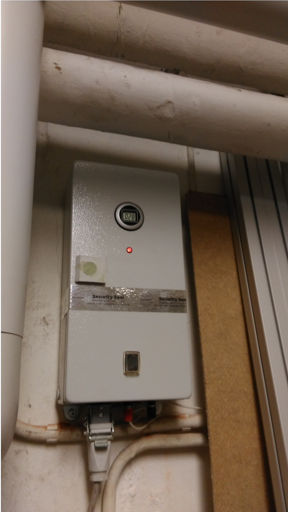
Figur 1.7 Plomberat likriktarskåp. Värdet på displayen varierade vilket tydde på pulsad ström.
