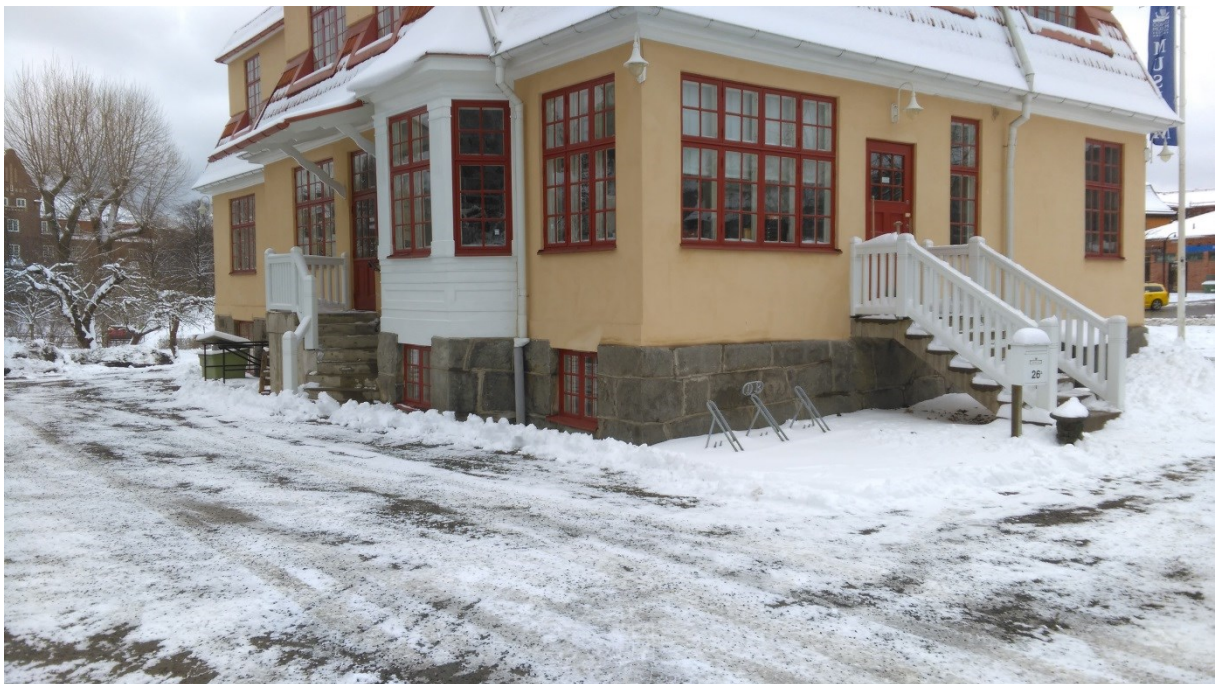
Figur 1.1 Lidingömuséet med elektroosmotiskt dränering i källarväggarna.
