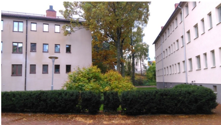
Figur 4.3 Hammarbyhöjden: Elektrosmossystem i högra huset, åskledare vid stuprännan på det vänstra.
